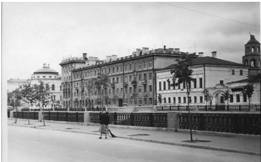
2-х этажный дом Балабанова на набережной Булака (Правобу- лочная ул., д. 35.). Семья А.Н. Николаева арендовала второй этаж. Казань. 1973 г. (В настоящее время дом снесён).
