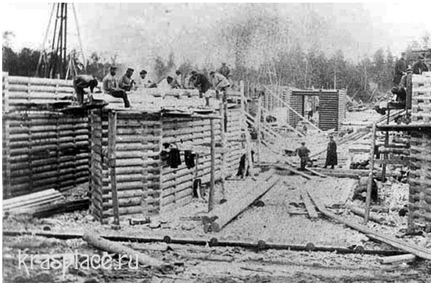
Строительство шлюза. 1899 г.
