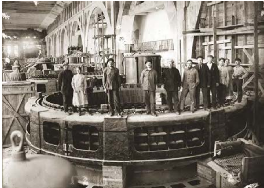
Статор гидрогенератора Волховской ГЭС, изготовленный на «Электросиле». 1926 г.
